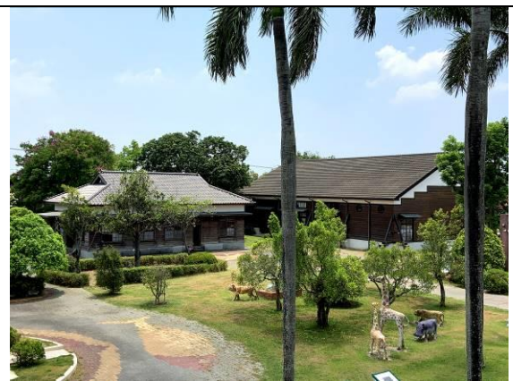
安溪國小內 2 座全木造歷史建築
